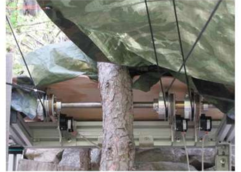
3 moteurs Robofocus pour gestion des câbles Sud
