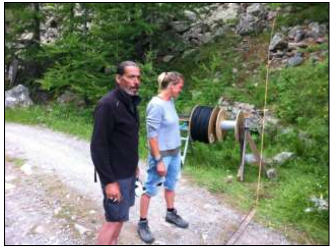
Figure 15 Le câble porteur en cours d'installation
