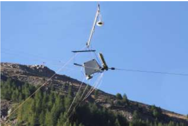
La nacelle approche du sol
