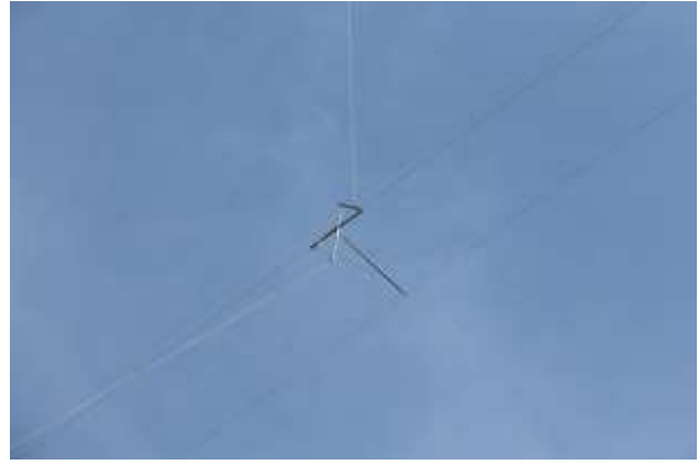
L'écarteur « Tetra » sur les cablettes Sud
