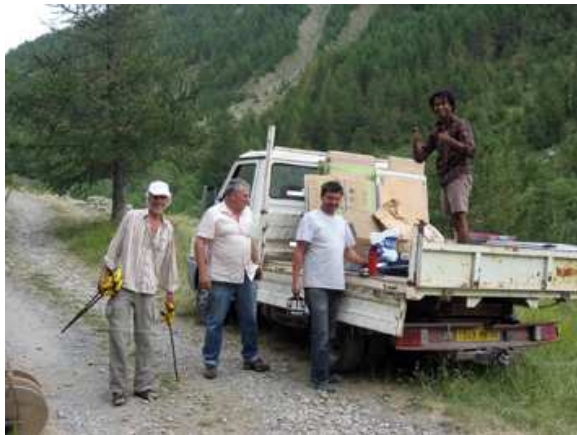
Arrivée du matériel sur le site
