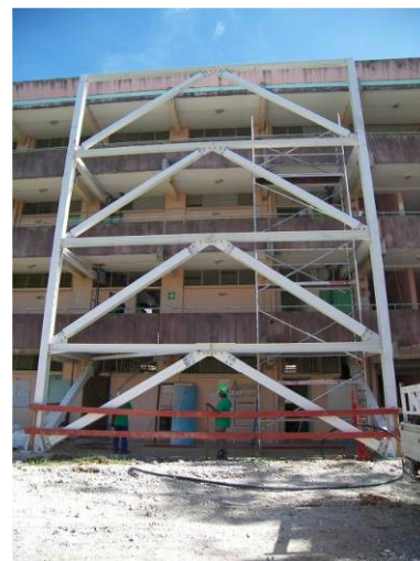
Renforcement sismique du collège de Dillon 1 - Fort-de-France (Martinique)
